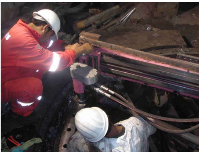
Fuente: P5223012.JPG Proceso de maquinado con fresadora CLIMAX PM5000
