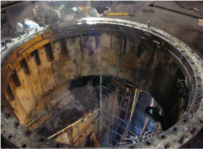
Fuente: DSC02473.JPG Asiento de la pista a maquinar
