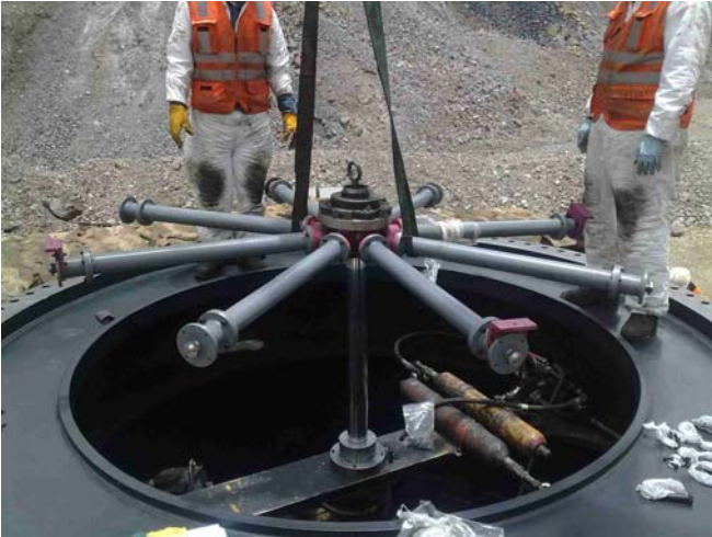
Fuente: 11032010849.JPG Instalación soporte superior
