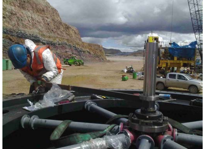
Fuente: 11032010852.JPG Centrado y nivelación
