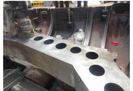
Fuente: DSC00840.JPG Trabajo terminado
