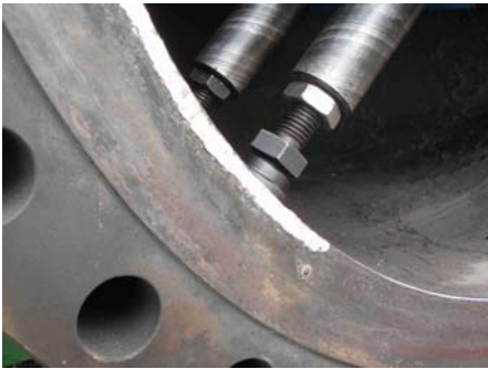
Anclaje de la refrentadora Fuente: P6230302.JPG
