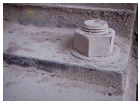
Detalle pernos de fijación del soporte
