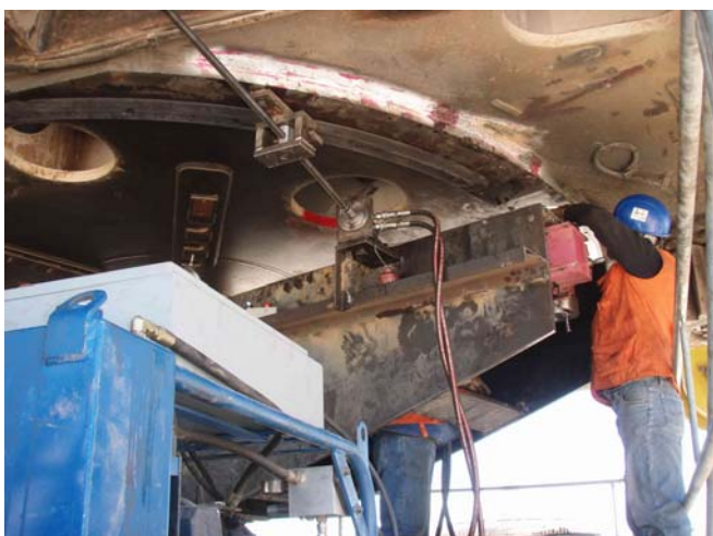
Fuente: PC231604.JPG Instalar fresadora PM5000 sobre el puente
