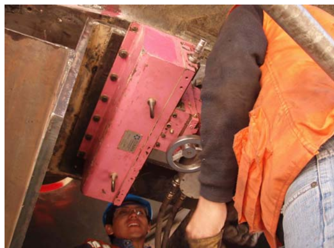
Fuente: PC231607.JPG Regular altura de la fresadora PM5000 sobre el puente
