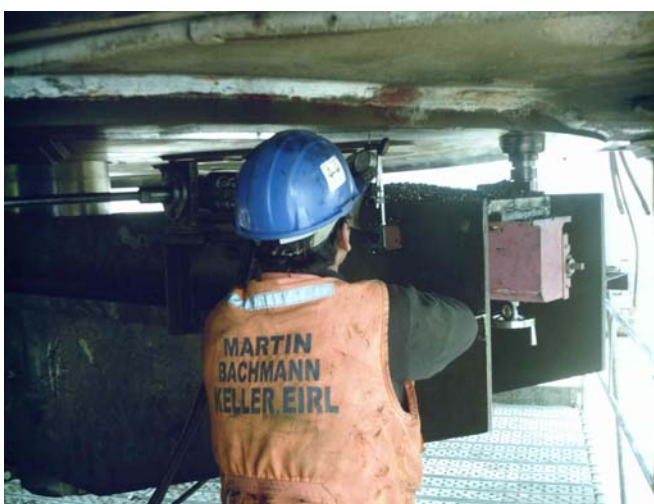
Fuente: SUNP0041.JPG Controlar el alineamiento de la fresadora
