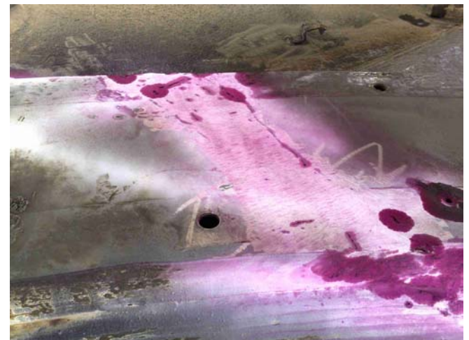
Fuente: 19122007045.JPG Detalle zona afectada, ya soldada (sin fresado)
