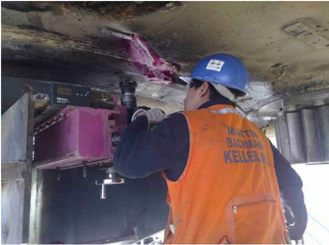
Fuente: 20122007063.JPG Maquinado de la zona afectada
