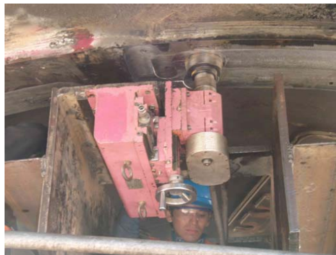
Fuente: PC231609.JPG Primeras pasadas con la fresa
