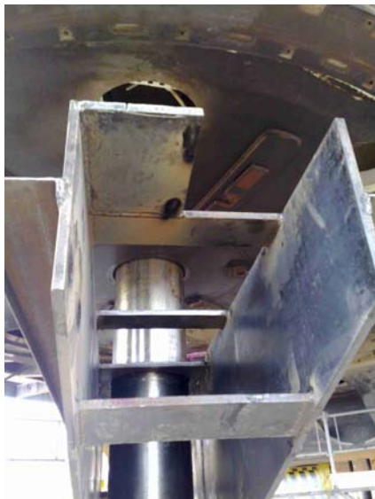
Fuente: 19122007055.JPG Introducir el puente, sin fresadora
