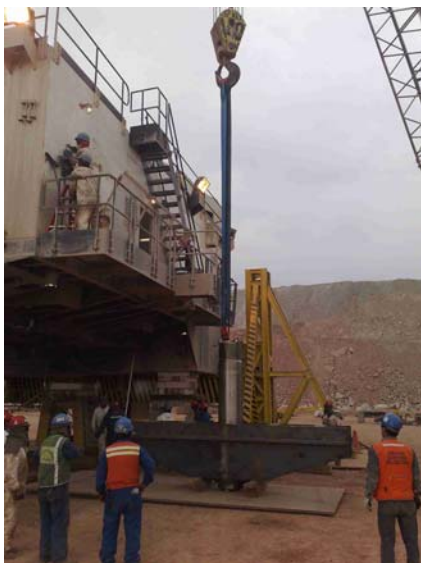
Fuente: 19122007050.JPG Introducir el puente
