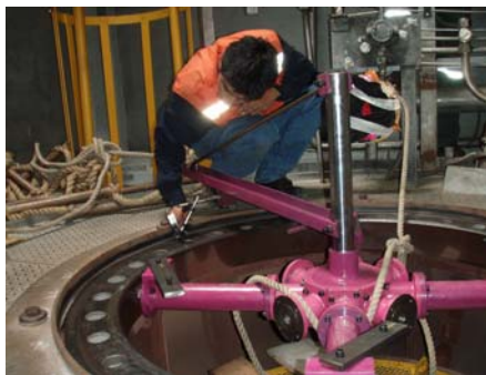
Fuente: P2061883.JPG Medición de la altura
