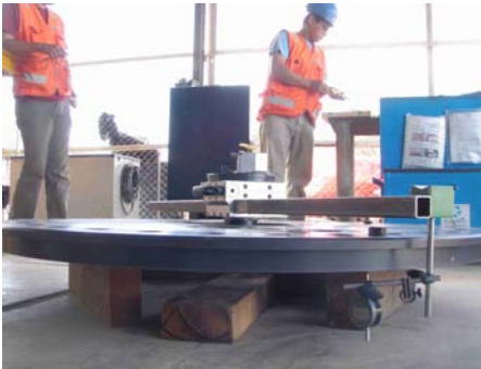
Fuente: P3050343 Proceso de centrado y nivelado
