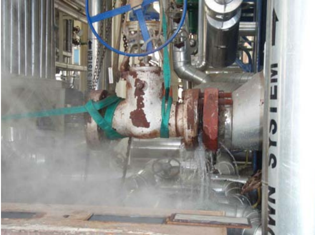
Fuente: PC140902.JPG Desmontaje de la válvula de 6" (1500 PSI)
