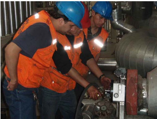
Fuente: PC140908.JPG Personal nuestro montando la refrentadora FF5000
